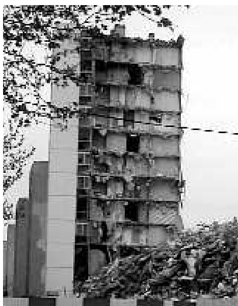
Ci-dessous la démolition de 312 logements sociaux du Grand L
